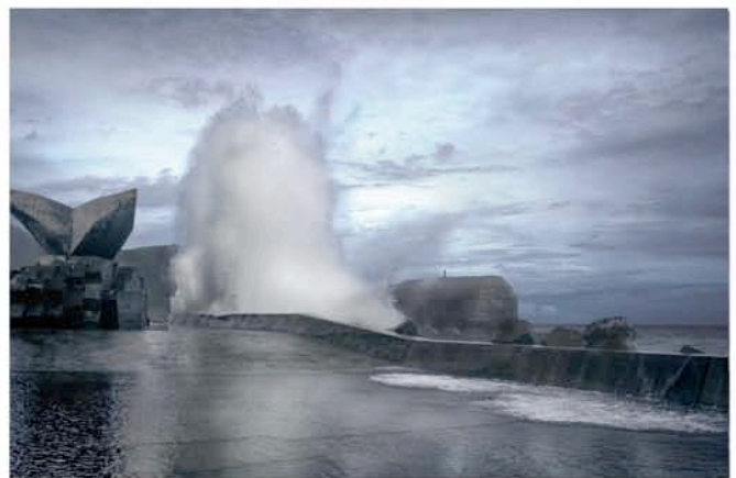
Bild 1. Stoßartige Wellenbelastung einer Küstenschutzanlage im Nordosten Taiwans während eines Taifuns im Jahr 1998
